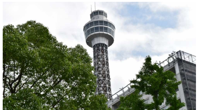
2009年に約31億円が投じられてリニューアルした横浜マリンタワー
